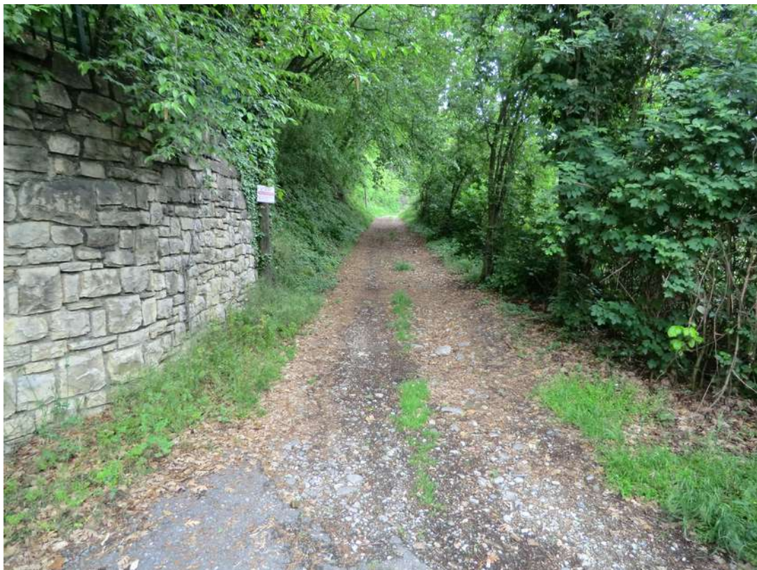
1 imbocco mulattiera in località "Codera"
