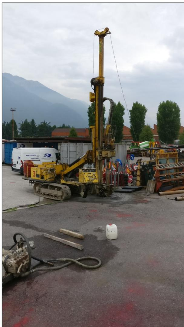
**Figura 8 - Esecuzione del sondaggio S3**
