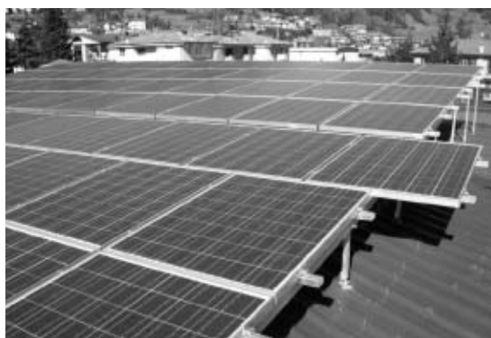
Un primo piano di impianto fotovoltaico
