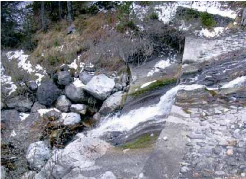
***Briglia a valle del ponte con evidenziazione dello scalzamento del materiale di rivestimento e degrado della fondazione: interventi del ripristino del rivestimento e del calcestruzzo di fondazione***
